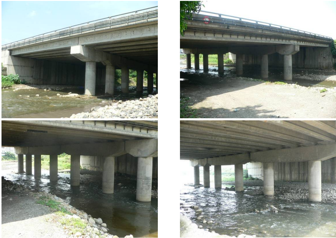
圖 4.2-3 國道一號 57K+809 新街溪橋現況照片圖
