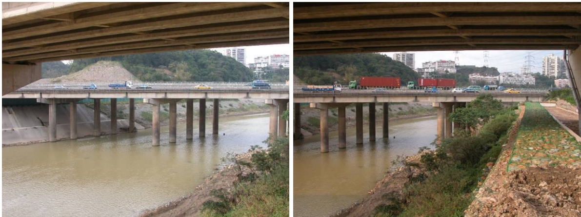
圖 4.1-5 國道一號 11K+936 基隆河四號橋現況照片及歷年河床變化圖
