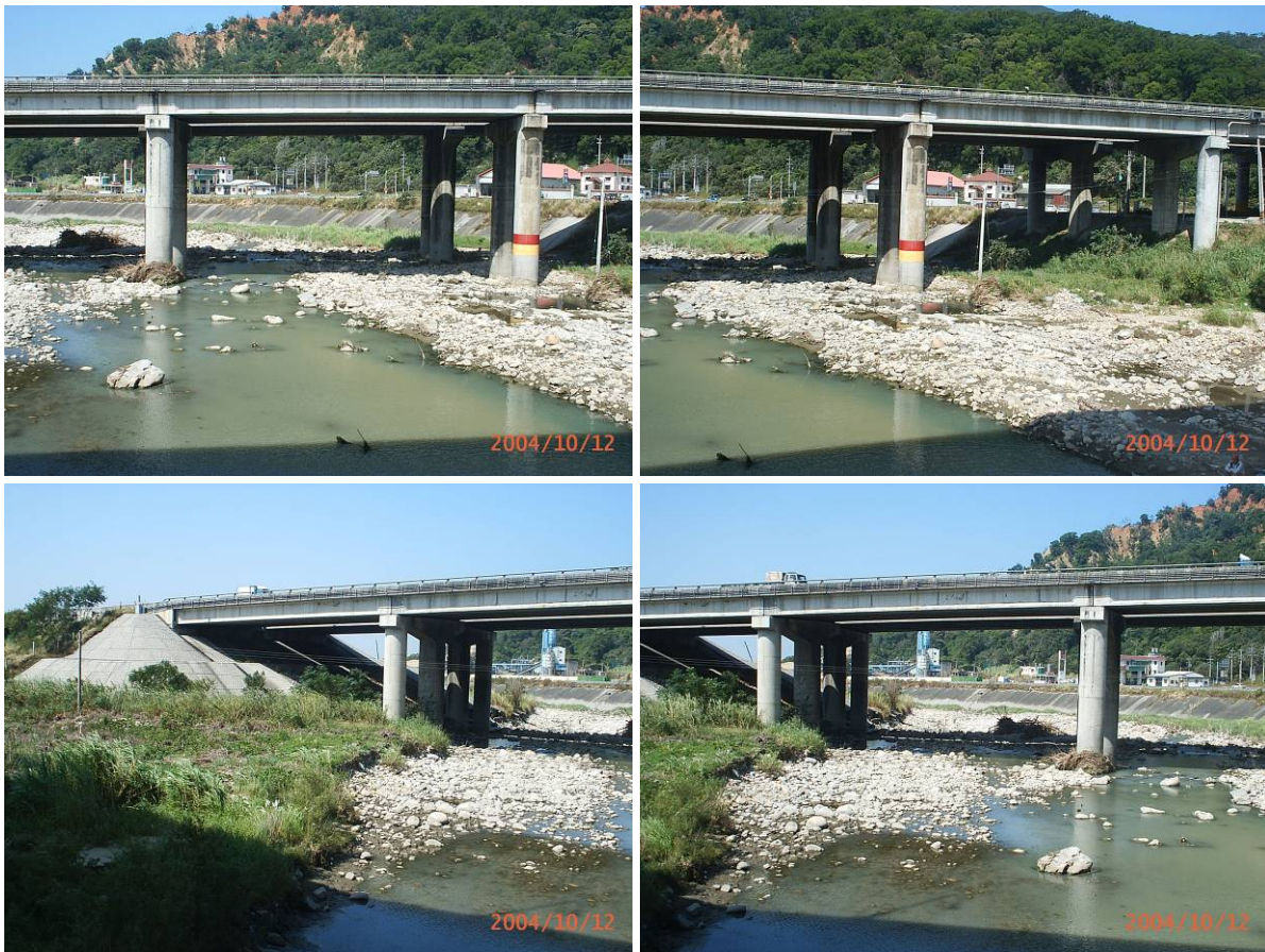
圖 4.1-18 國道一號 154K+673 景山溪橋現況照片及歷年河床變化圖
