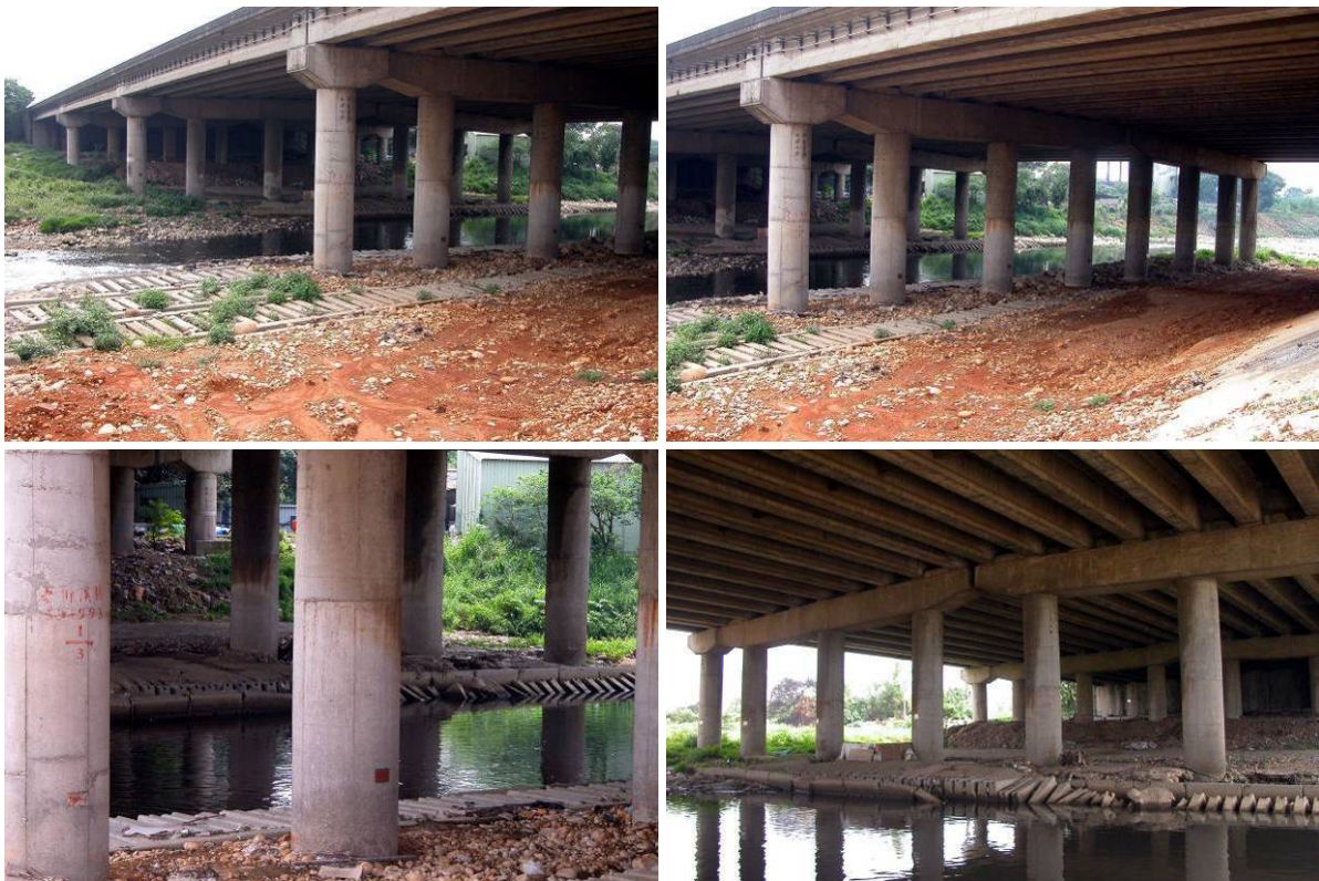
圖 4.2-2 國道一號 59K+993 老街溪橋現況照片及歷年河床變化圖
