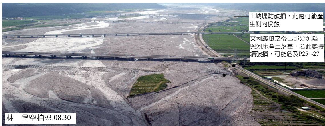
圖 4.1-20 國道一號 155K+498 大安溪橋現況照片及歷年河床變化圖(二)
