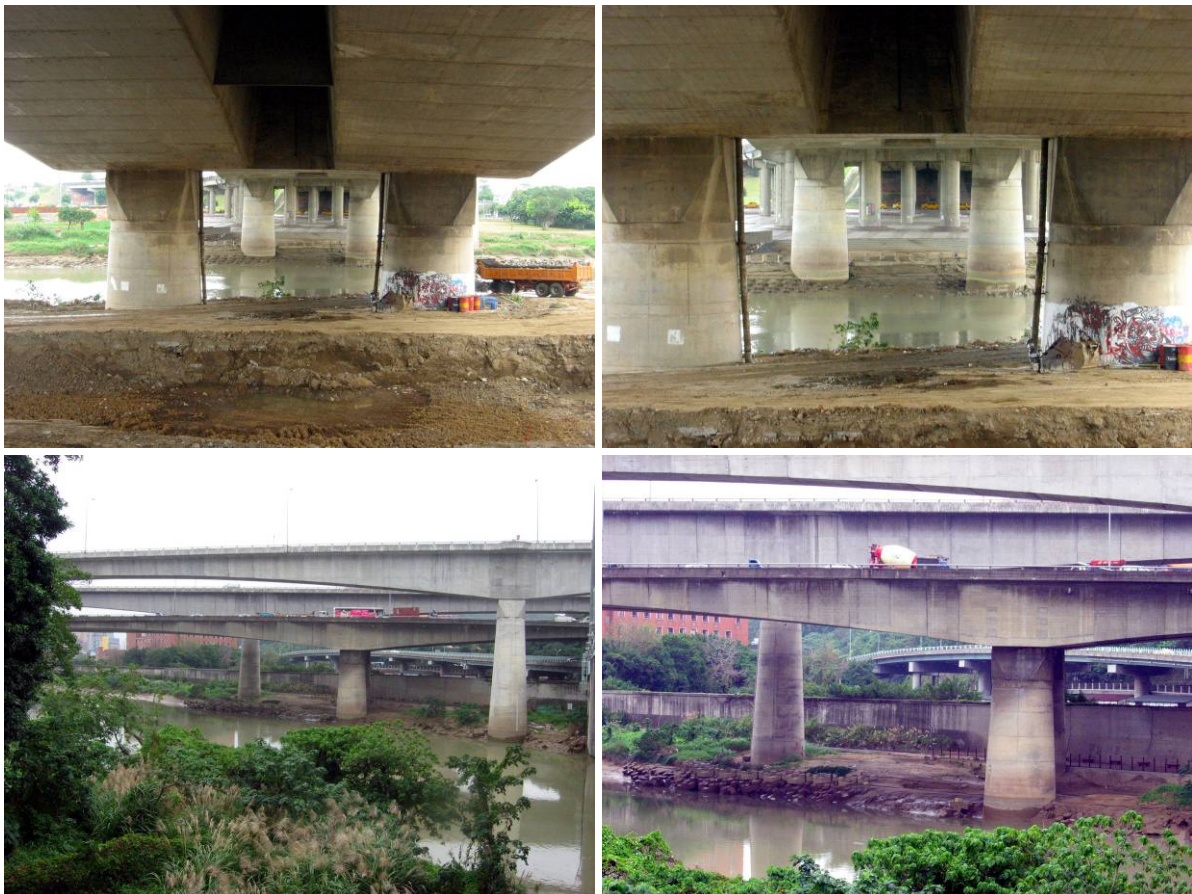
圖 4.1-7 國道一號 23K+877 圓山橋現況照片及歷年河床變化圖
