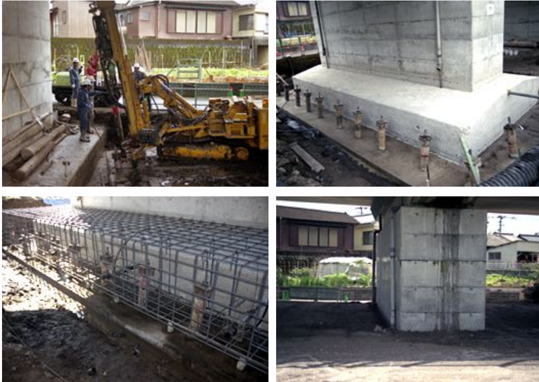
日本宮崎縣平成13年地方道路整備工事(耐震補強)
