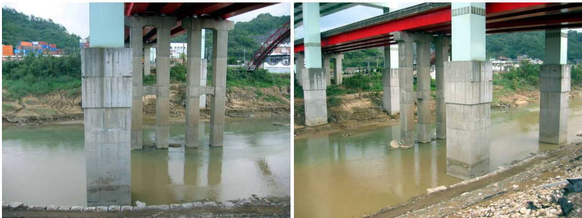
圖 4.1-1 國道一號 2K+500 八堵匝道橋現況照片及歷年河床變化圖
