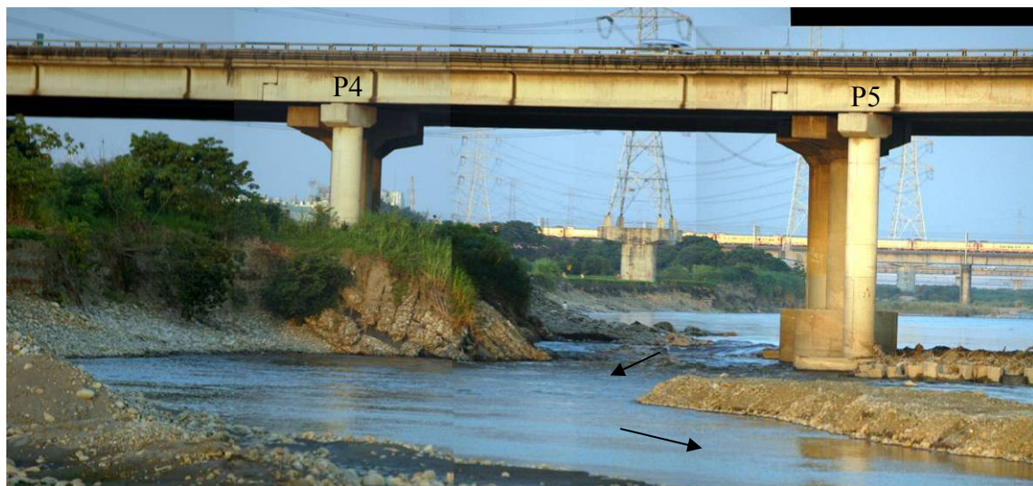
圖 4.1-25 國道一號 191K+221 烏溪橋現況照片及歷年河床變化圖(二)
