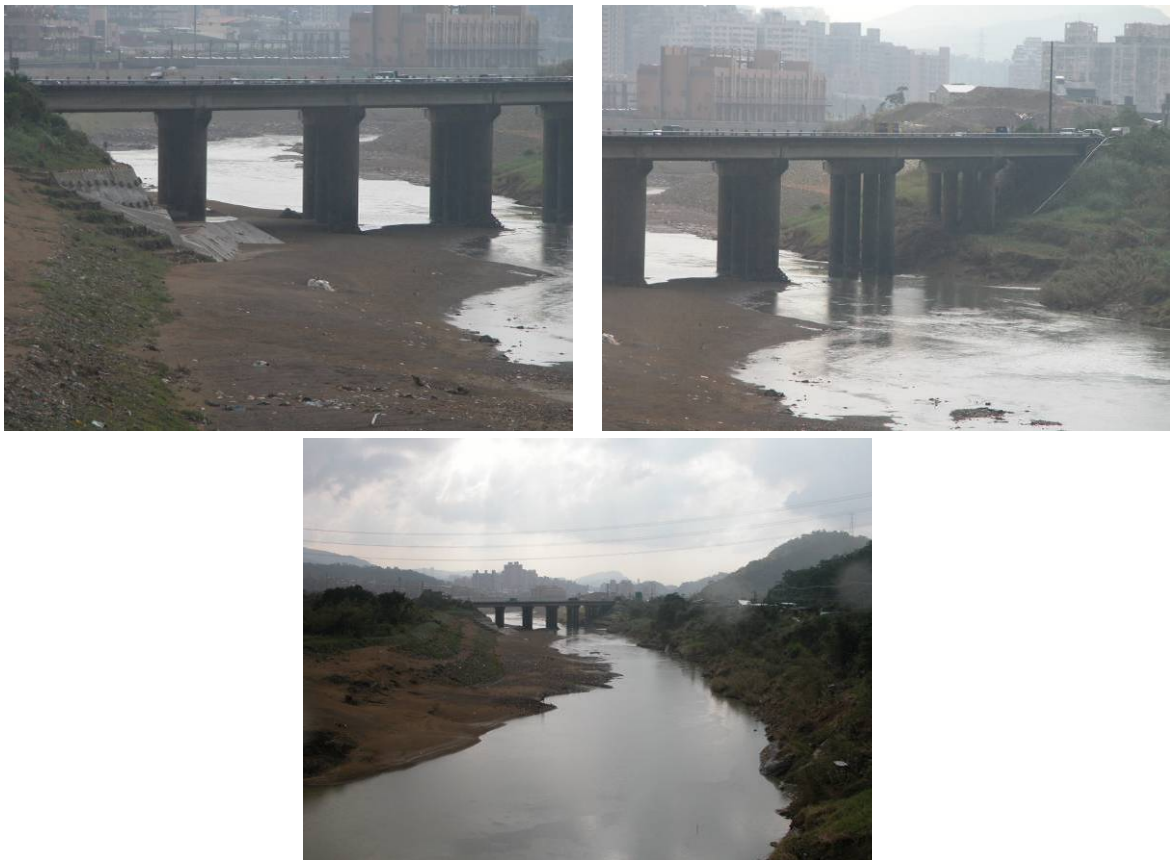
圖 4.1-3 國道一號 7K+860 基隆河二號橋現況照片及歷年河床變化圖
