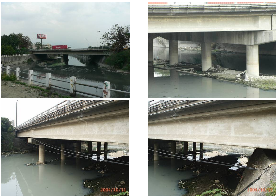
圖 4.2-4 國道一號 372K+729 前鎮河橋現況照片圖
