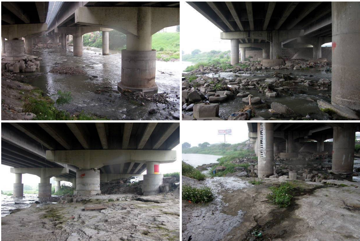
圖 4.1-23 國道一號 179K+347 筏子溪橋現況照片及歷年河床變化圖
