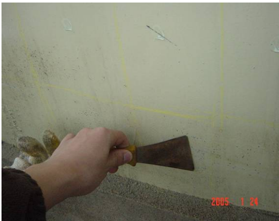
圖 12.2-5 清除鋼板表面之鏽皮
