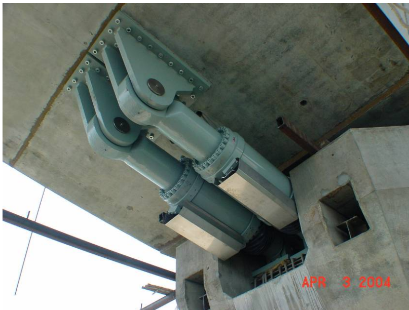
圖 7.6-2 台灣高速鐵路使用之衝擊傳遞裝置
